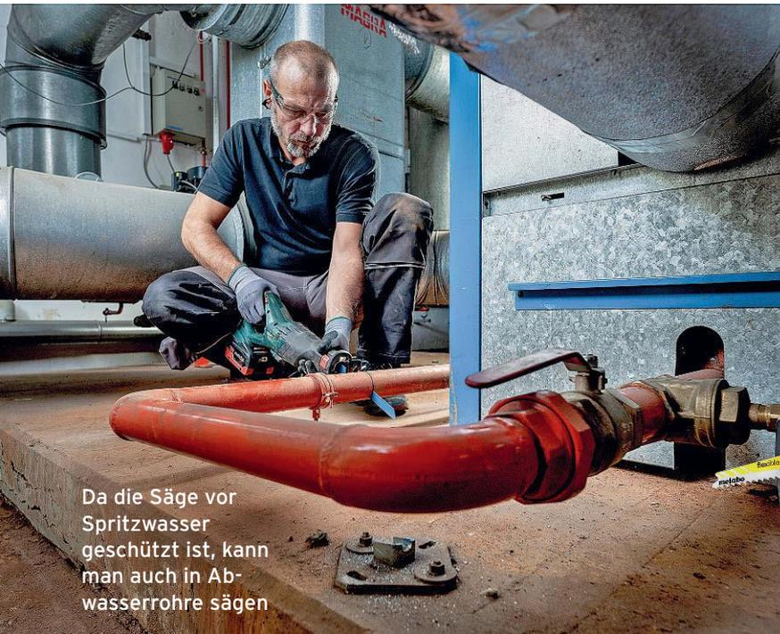
Da die Säge vor Spritzwasser geschützt ist, kann man auch in Abwasserrohre sägen
