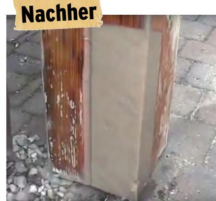
Die Reparaturmasse Schicht für Schicht luftblasenfrei auftragen und modellieren
