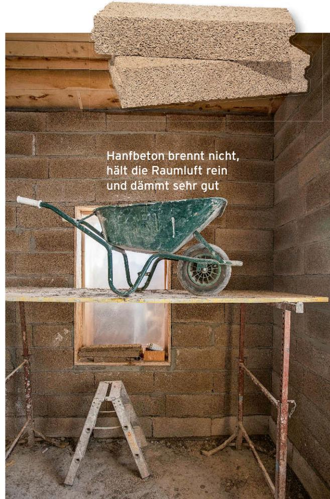
Hanfbeton brennt nicht, hält die Raumluft rein und dämmt sehr gut
