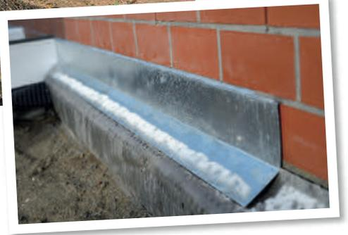
Als konstruktiver Witterungsschutz sind maßgefertigte Bleche ideal
