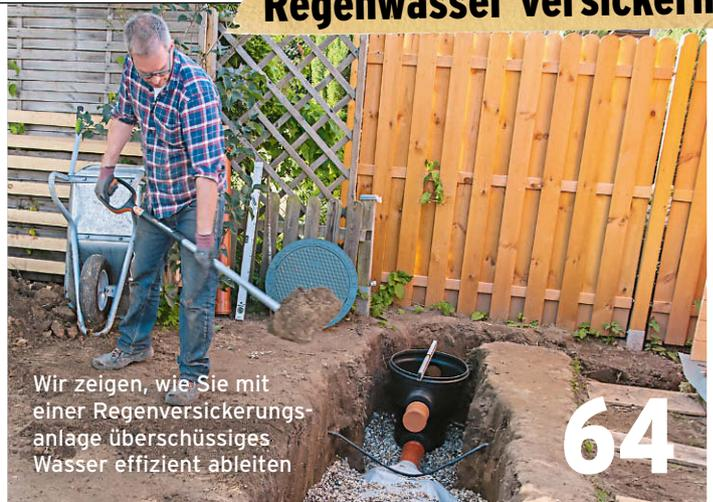
Wir zeigen, wie Sie mit einer Regenversickerungsanlage überschüssiges Wasser effizient ableiten
