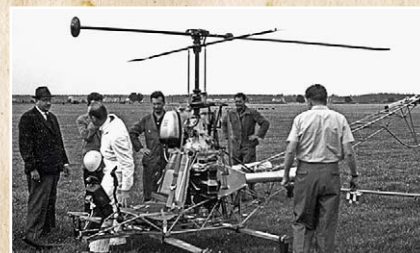
Innovativ: Einblatt-Rotor aus GFK
