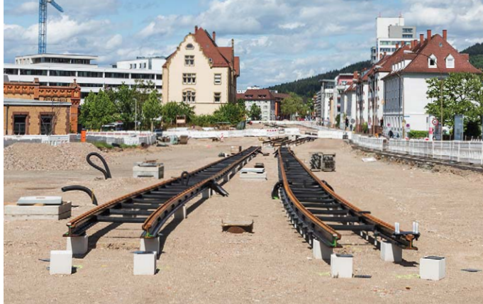
Die ersten neuen Gleise liegen schon für die Trasse Waldkircher Straße, bis zur ersten Fahrt 2023 dauert es allerdings noch
