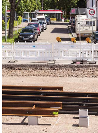
Dieser Blick in eine Seitenstraße verdeutlicht, wie nah beieinander jetzige und künftige Streckenführung liegen
