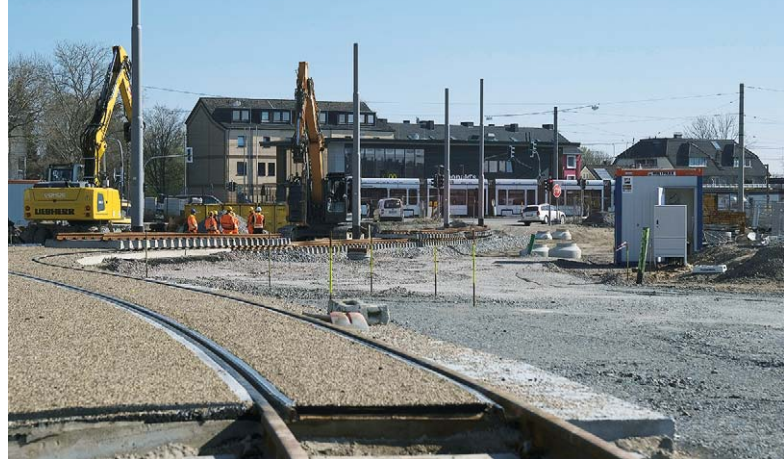
Bochum: Langsam wächst die Trasse auf dem alten Opelwerksgelände, hier der Bauzustand von Anfang April südwestlich der Haltestelle Mark 51°7, wo die Strecke ans Bestandsnetz anschließt
