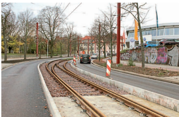
Beginn der Gleisverschlingung auf der Warschauer Straße zwischen Dodendorfer Straße und der Bahnbrücke
