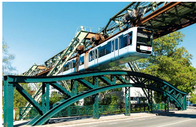
Wuppertal: Ab August soll die Schwebbahn als Wahrzeichen der Stadt endlich wieder täglich im Einsatz stehen, seit August 2020 fuhr die Bahn nur sehr eingeschränkt MICHAEL BEITELSMANN
