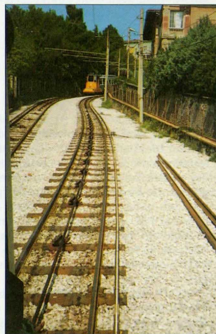
Bild 4. Blick talwärts. Gut sichtbar ist die Rollen- und Seilführung.
