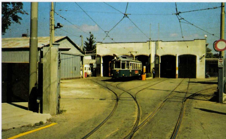
Bild 1. Die Straßenbahnremise in Opicina. Alle Fotos: P. Kaldarar
