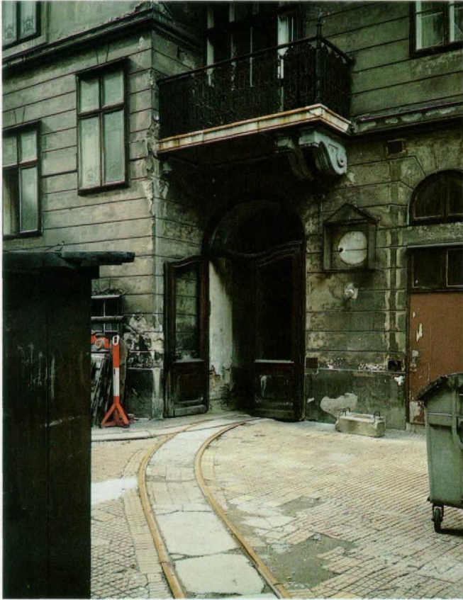
Bild 1. Blick vom Innenhof in Richtung Hausflur.
