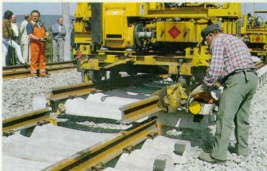
Bild 1. Wie bei der Modellbahn: Das neue Gleisstück wird abgehängt . . .
