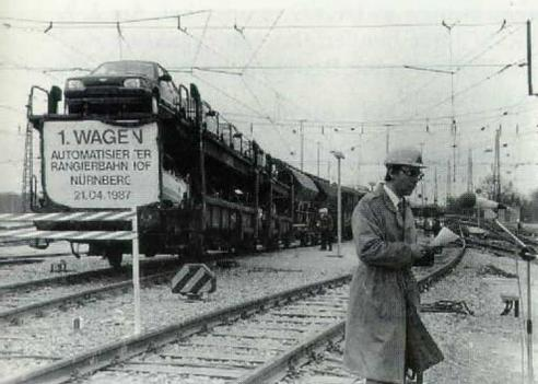
Bild 3 und 4. Bevor der erste Wagen über den neuen Ablaufberg rollen konnte, wurden in einer spektakulären Aktion die Gleisanlagen umgebaut; auch diese Szene wirkt wie „Anlagenbau in 1:1“. Mit Umbau und Automatisierung des Rangierbahnhofs wurden auch Material- und Betriebsaufwand sowie die Unfallgefahr entscheidend verringert.
