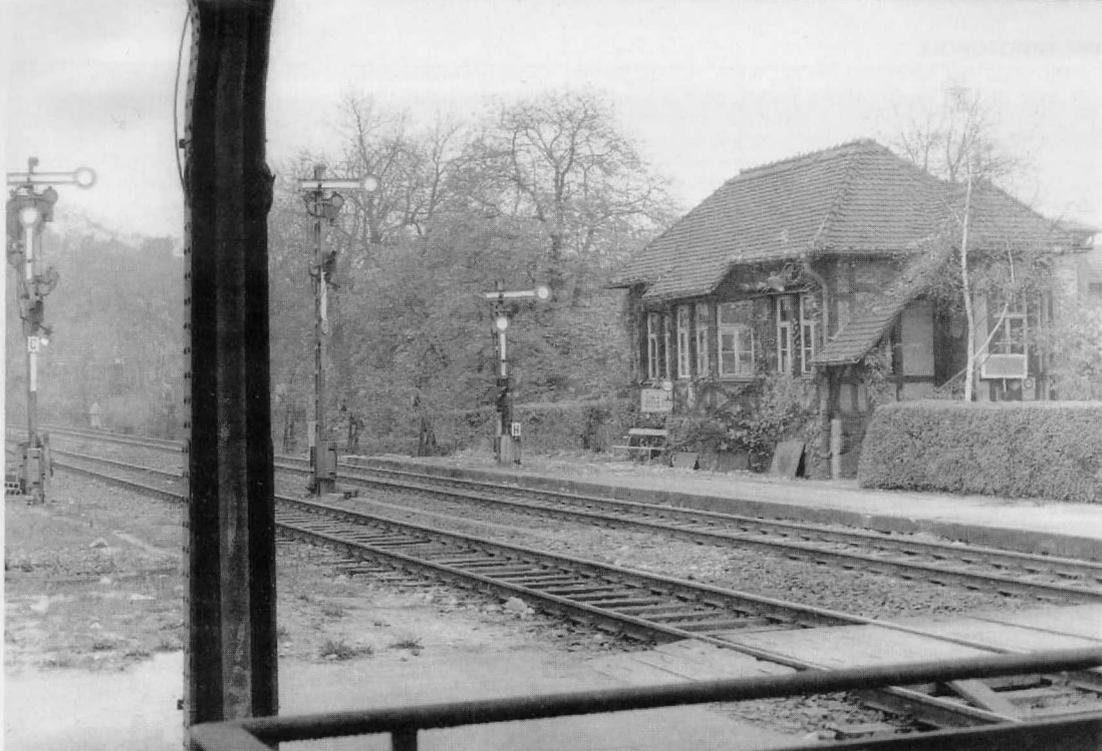
Bild 2. Ebenfalls von Jörg Fladt-Stähle entdeckt: ein kleines Stellwerk an der westlichen Bahnhofsausfahrt von Jena (DDR). Auch hier wieder jede Menge Anregungen für den Modellbahner, sei es nun das „Stummelsignal“ mit zwei Signalflügeln, das Stellwerksgebäude in der für die Region typischen Bauweise, der Bohlenübergang im Vordergrund oder die im Freien aufgestellten Signaltafeln.
