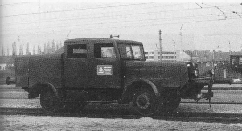
Abb. 1. Dieschwere Faun-Zugmaschine mit Eisenbahnrädern und Puffern steht noch bei einer österreichischen Firma im Dienst.
