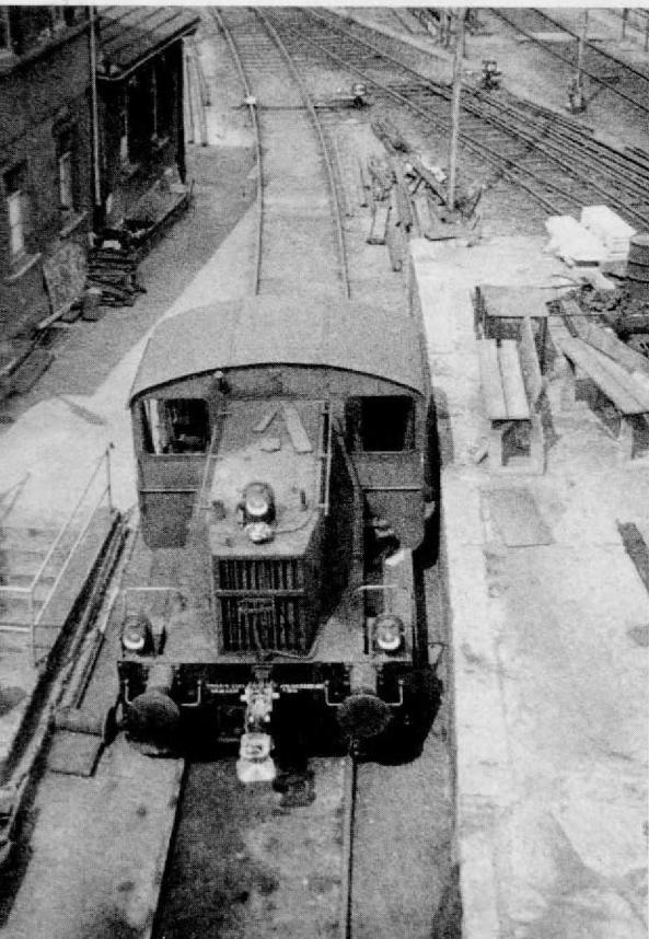
Abb. 1. Die Kleinlok lichtete MIBA-Mitarbeiter J. Zeug, Trier, bereits 1968 im Bw Hagen-Eck ab; sie ist mit der BSI-Rangier-Kupplung (Abb. 2–5) versehen und wirkt an der Lok verhältnismäßig zierlich.
