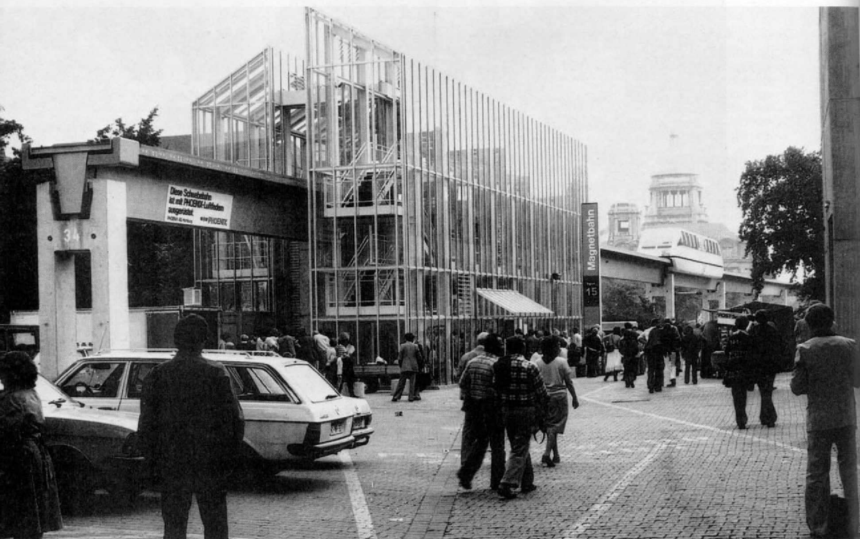
Abb. 54. Die Endstation der Magnetbahn bei den Ausstellungshallen mit dem „einschwebenden“ Magnetzug; am linken Bildrand ist der Querschnitt der aufgeständerten Fahrbahn gut zu erkennen.
