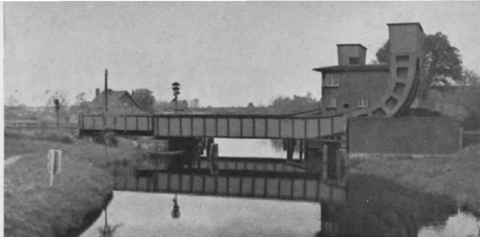
Abb. 6. Zwei nebeneinander liegende kleinere Klappbrücken (vgl. Abb. 9) über den Ems-Jade-Kanal bei Varel. Eine weitere Anregung, wie man die Pola-Brücke gleich zweifach einsetzen könnte!
