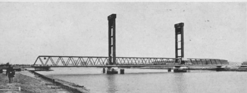
Abb. 3. Eine moderne Hubbrücke mit den charakteristisch hohen Portalen: die Kattewyk-Brücke im Hamburger Hafen (von der wir leider kein „gehobenes“ Foto besitzen). Ist eine größere, pfeilerfreie Schiffsfahrtsöffnung freizuhalten, wird häufig die Hubbrücke gewählt. Hierbei befriedigen ästhetisch nicht immer die beiden Hubtürme, die bei großem Querschnitt je nach freizuhaltender lichter Höhe sehr hoch und damit auch sehr teuer werden können. (Fotos 2 u. 3: DB)
