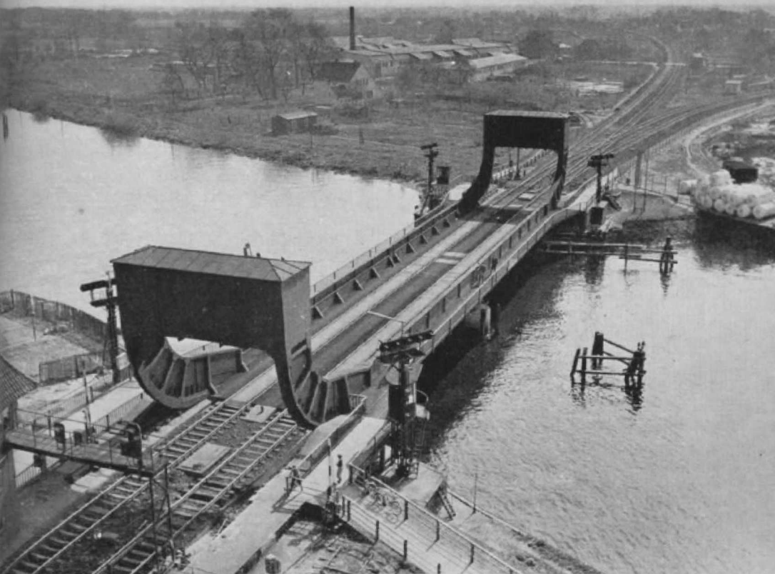
Abb. 1. Die Doppel-Klappbrücke über die Hunte in Oldenburg wurde 1955 gebaut und hat zwei Klappen von jeweils 29,71 m Länge, die mit geringer zeitlicher Versetzung gehoben bzw. gesenkt werden. Was auch im Kleinen berücksichtigt werden sollte: die V-förmigen Abweiser zum Schutz des Mittelpfeilers vor Schiffen. (Foto: DB)
