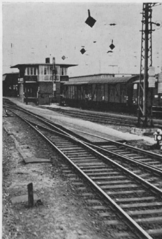
Abb. 1. Etwas primitiv anmutend, aber durchaus zweckentsprechend: der mit Holzbohlen verlängerte Bahnsteig in Münster Hbf. Es sieht fast so aus, als wäre der für diese Notlösung verantwortliche DB-ler ... Modelleisenbahner!
