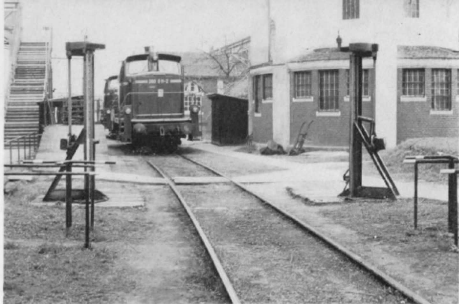
Abb. 1. Hebewinden für Radsatzwechsel im Bw Plochingen – entdeckt und fotografiert vom Verfasser.
