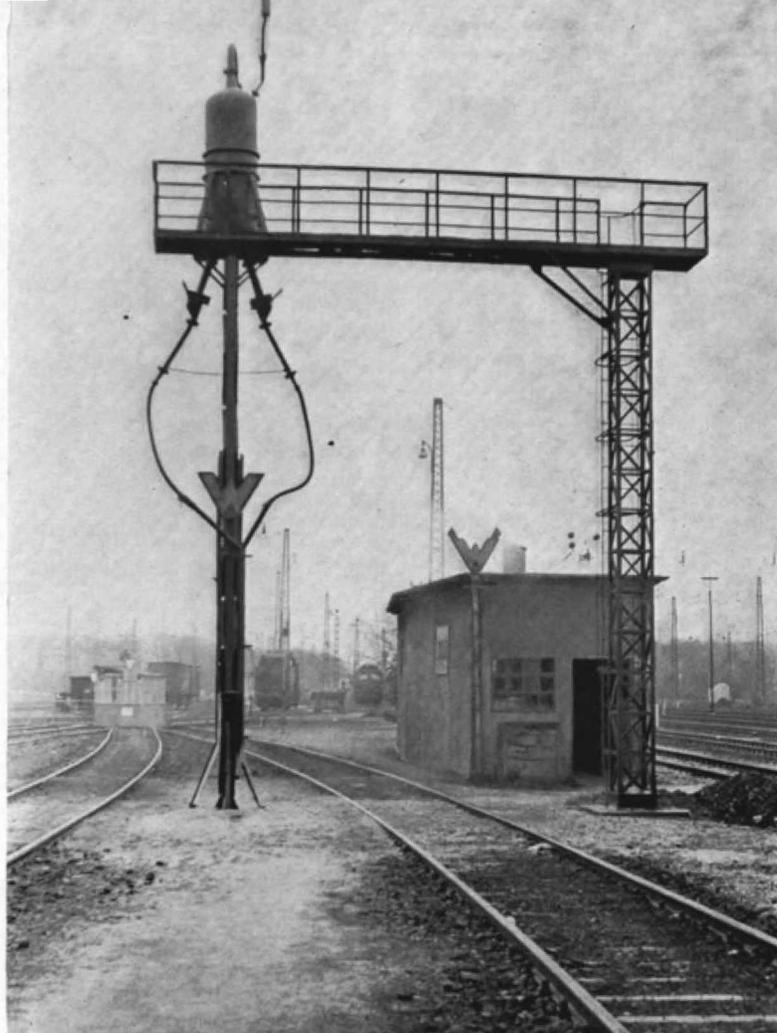
Abb. 1. Die Besandungsanlage in Köln-Eifeltor. Auf dem Gerüst ist kein Trockensand-Hochbehälter angebracht, sondern ein sog. Umkehrkasten mit Entlüftungsfilter. Der Druckbehälter dürfte sich im Gebäude befinden. In diesem Fall wird der Sand mit Druckluft (in den Umkehrkasten) gefördert — jedoch nur im Augenblick der Besandung —, dort von der Luft getrennt und rieselt unmittelbar in den Sandbehälter des Fahrzeugs.
