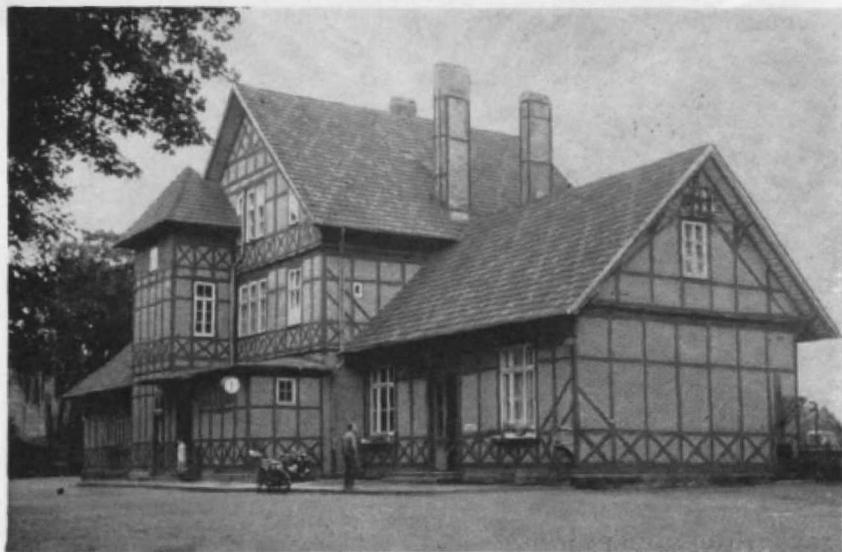
Abb. 1. Die Straßenseite des Empfangsgebäudes vom Bf. Bad Liebenstein/Thür., mit seinem Fachwerk und den Füllungen aus weißverfugten roten Backsteinen ein schmuckes Gebäude.
