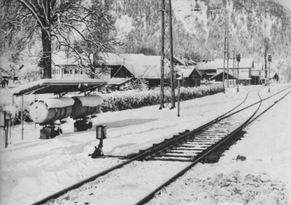
Abb. 1. Eine propangasbeheizte Weiche im Bf. Oberau (an der Strecke München—Garmisch—Innsbruck) nebst 2 Propangasbehältern — zugleich aber auch ein stimmungsvolles Winterbild, sodaß man am liebsten gleich auch dorthin abreisen möchte! Bei der Signaltafel im Mittelgrund handelt es sich um eine Neigungswechseltafel Nr. 12 und zwar gibt die nach rechts zeigende Keilspitze an, daß ab hier die Bahn wieder horizontal verläuft.
