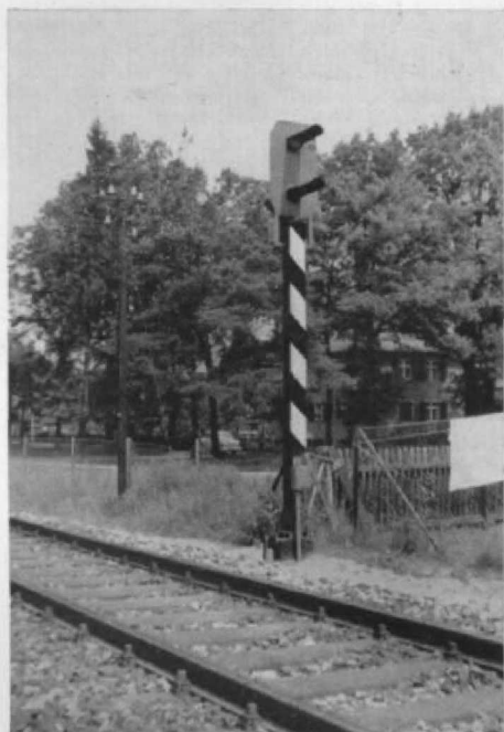
Abb. 1 zeigt die neuere Ausführung des Signals Ne 10. Sie unterscheidet sich von der älteren (siehe Abb. 6) durch die abgeschrägten Ecken des Signalschildes.
