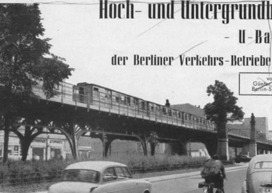
Abb. 1. Hochbahnstrecke zwischen Nollendorplatz und Bülowstraße (Stahlkonstruktion).
