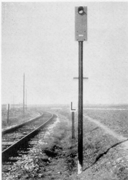
Abb. 7. Höchstens als Altrappe aufzustellen: das Lokführerwarnsignal (Masthöhe 4 m)
