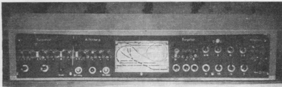
Abb. 3. Das im Bahnhofsgebäude eingebaute Schaltpult mit dem Gleislauflichtbild, das unten vergrößert erläutert wird.
