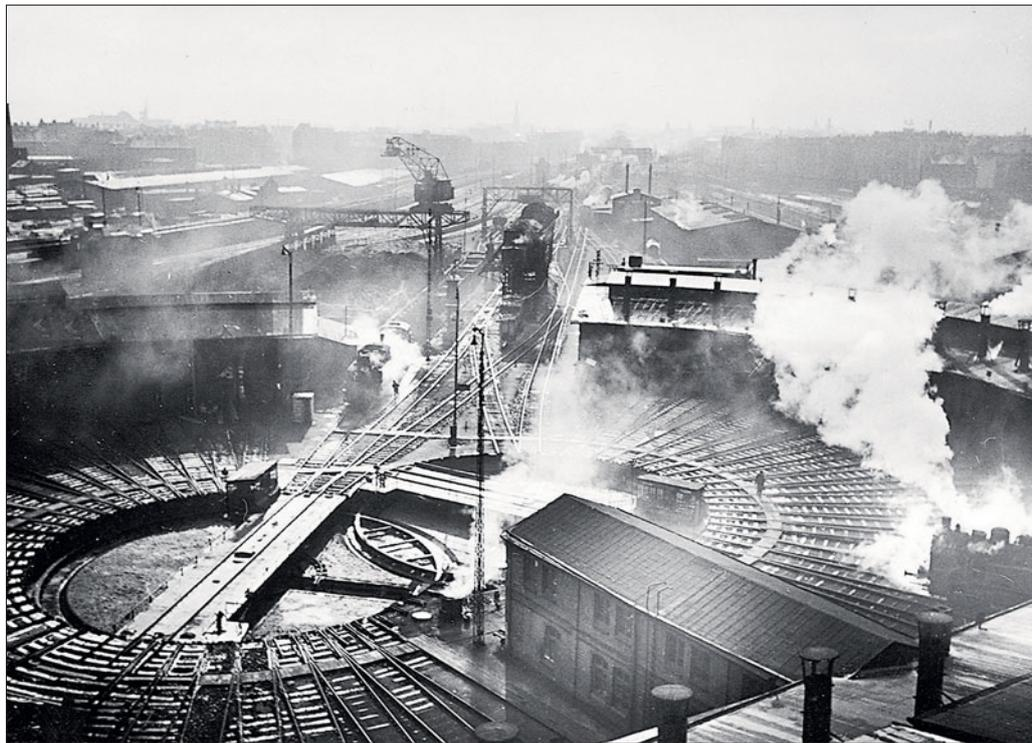
Das Groß-Bw Hamburg Altona mit seiner besonderen Doppeldrehscheibe und dem riesigen Ringlokschuppen mit 57 (!) Ständen. Foto: Slg. Neumann
