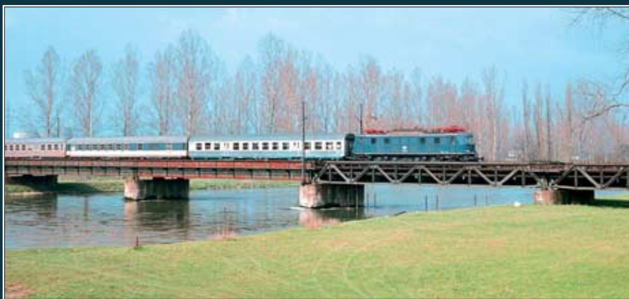
Plattling liegt noch in der weiten Ebene des Gäubodens. Bereits in der Epoche IV überquert eine E 18 mit Silberlingen und Popwagen die dortige Isarbrücke. Foto: Siegfried Bufe
