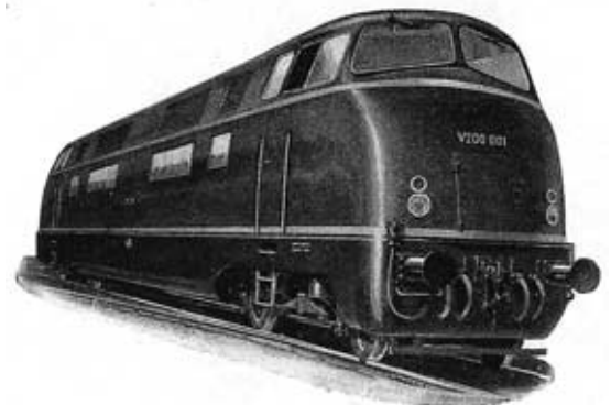
Neueste schwere Diesellok (V 200) der DB, 2000 PS, für Reise- und Güterzugdienst
