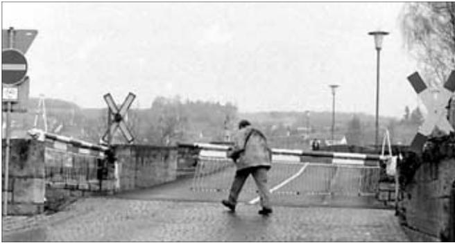
Das Zugpersonal bedient die Schranke an der alten Mainbrücke von Ochsenfurt per Handbetrieb. Verschwenkt wird in der Horizontalen.
