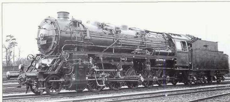
**Mitteldrucklok 44 012 (Henschel, 1933) auf dem Gelände des LVA Grunewald. Die Lok ist für die leistungstechnische Untersuchung mit Indiziereinrichtung ausgerüstet. Abb.: Hubert/Sammlung Weisbrod**
