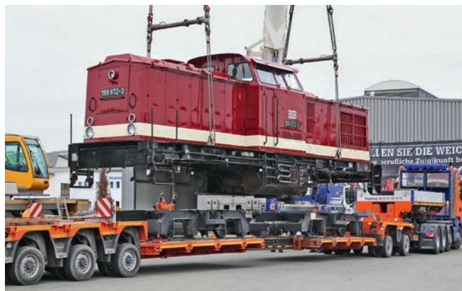
Mit vereinten Kräften heben zwei Autokrane 199 872 auf die Drehgestelle.
