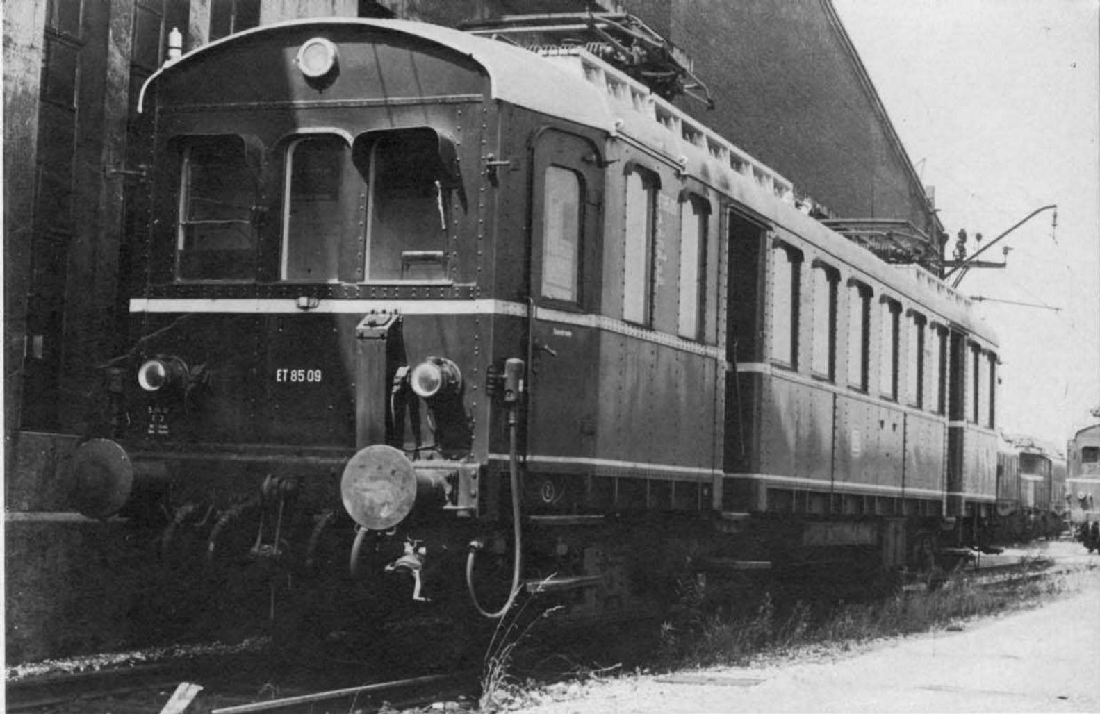
**Bild 1:** Bis zur Betriebsnummer ET 85 09 und ES 85 04 hatten die Fahrzeuge hinten angeschlagene Türen zu den Führerräumen.
