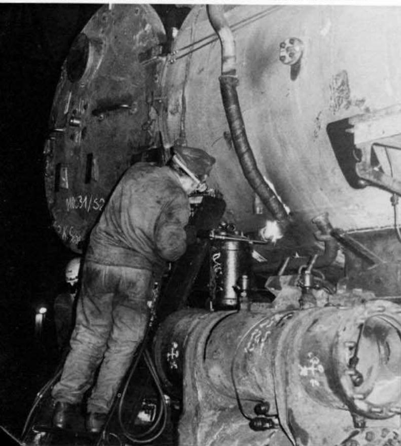
Bild 7: An der 01 533 vom Bw Saalfeld wird die Doppelverbund-Luftpumpe instandgesetzt.
