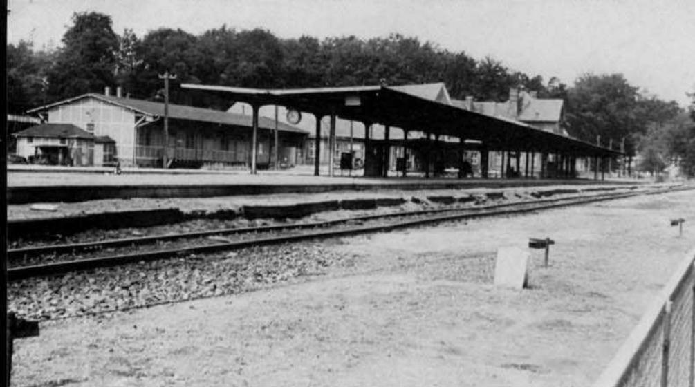
**Bild 5:** Bahnhof Heringsdorf. Hier endeten früher auch die Bäderzüge von Berlin. Ein Teil der großzügig angelegten Gleisführung (rechts vorn und hinter dem Bahnsteig) wurde zwischen 1945 und 1946 abgebaut. Ebenso ein Gleis der bis dahin zweigleisigen Strecke Bf. Heringsdorf – Bf. Seebad Ahlbeck. Heringsdorf ist Kopfbahnhof, im Hintergrund schließt ein Prielbock die Strecke ab.
