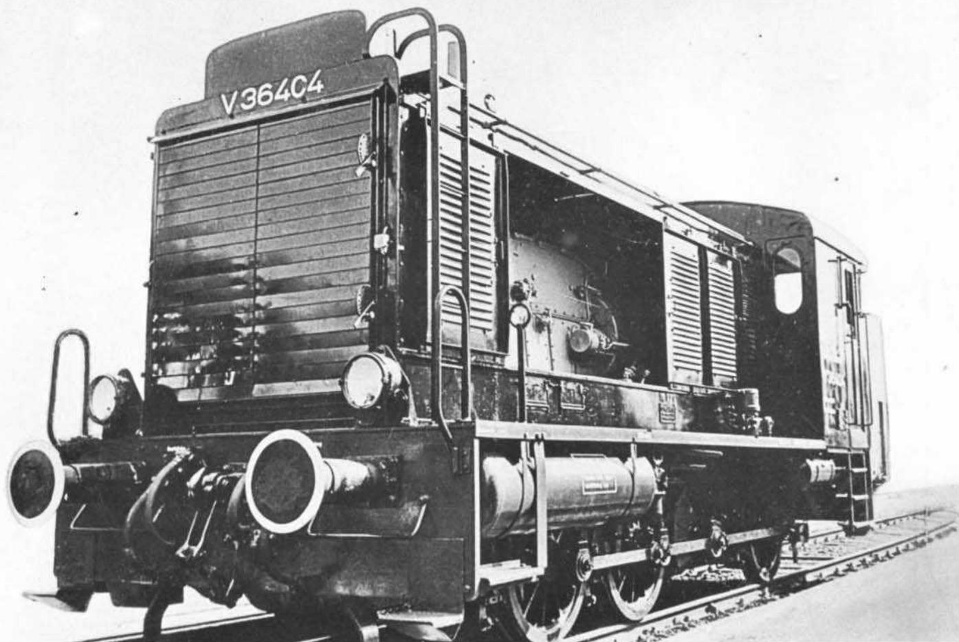
**Bild 1:** Die V 36 404 (mit ihren großen Vorratsbehältern) entspricht weitgehend dem Modell der M+V V 36. Die Schiebetüren für den Motorraum sind wie bei unserem Modell, mit Lüfterschlitzen ausgestattet. Sammlung: HJO
