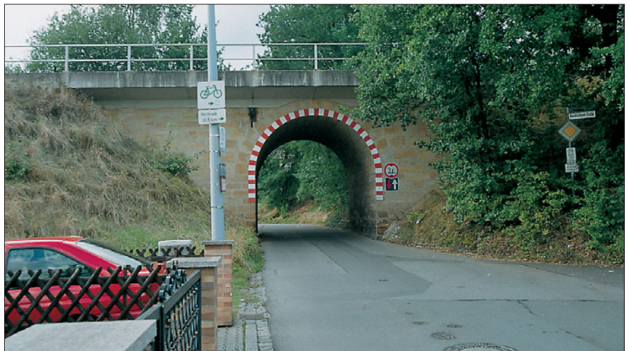
Kleine Steinbogenbrücke mit schöner Sandsteinmauerung in Lauf. In jüngerer Zeit überbaute man sie mit einer Fahrbahnwanne aus Beton einschließlich der Gehwegkonsolen. Auffällig: Wegen der niedrigen Durchfahrt erhält die Brücke die typisch rot-weiße Warnblende um den ganzen Bogen.
