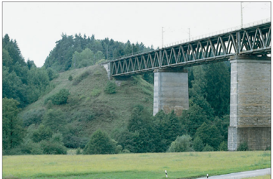
Der ICE auf seinem Weg von Regensburg nach Nürnberg. Die große Fachwerkbrücke bei Beratzhausen besitzt einen hohen Träger mit V-Streben und überspannt das gesamte, idyllisch gelegene Tal.
