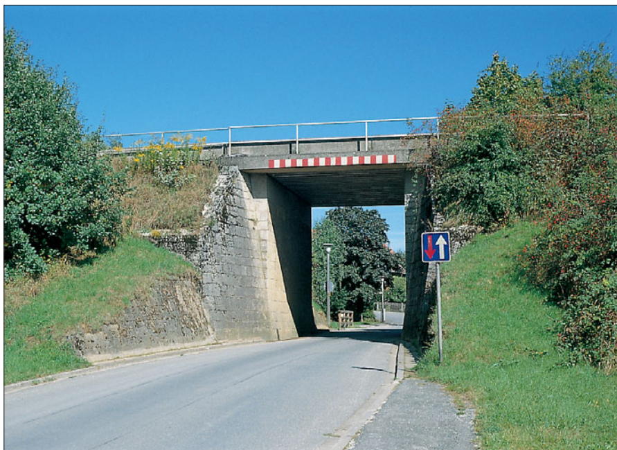
Die „Standardbrücke“ aus der Epoche III, eine Stahlbetonbrücke für kleinere Straßen und Feldwege, zeigt sich hier mit verschiedenen schwach geneigten Stützmauern.
