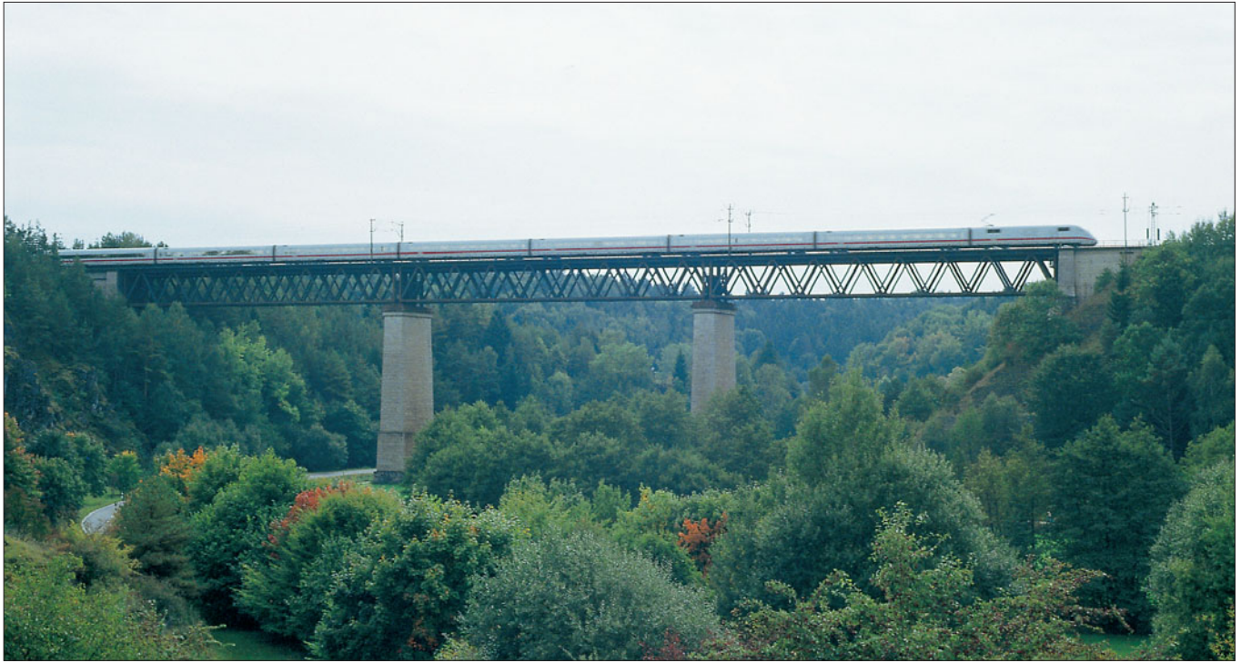
Der ICE auf seinem Weg von Regensburg nach Nürnberg. Die große Fachwerkbrücke bei Beratzhausen besitzt einen hohen Träger mit V-Streben und überspannt das gesamte, idyllisch gelegene Tal.
