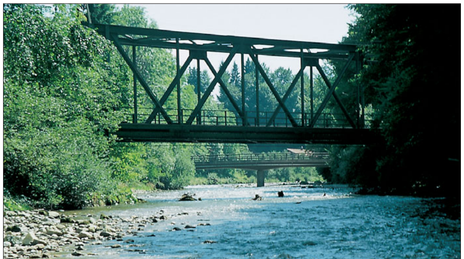
Ein hoher Stahlträger führt die Nebenbahn Ruhpolding–Traunstein über einen Fluss. Dahinter ist schwach eine modern geschwungene Fußgängerbrücke zu entdecken.
