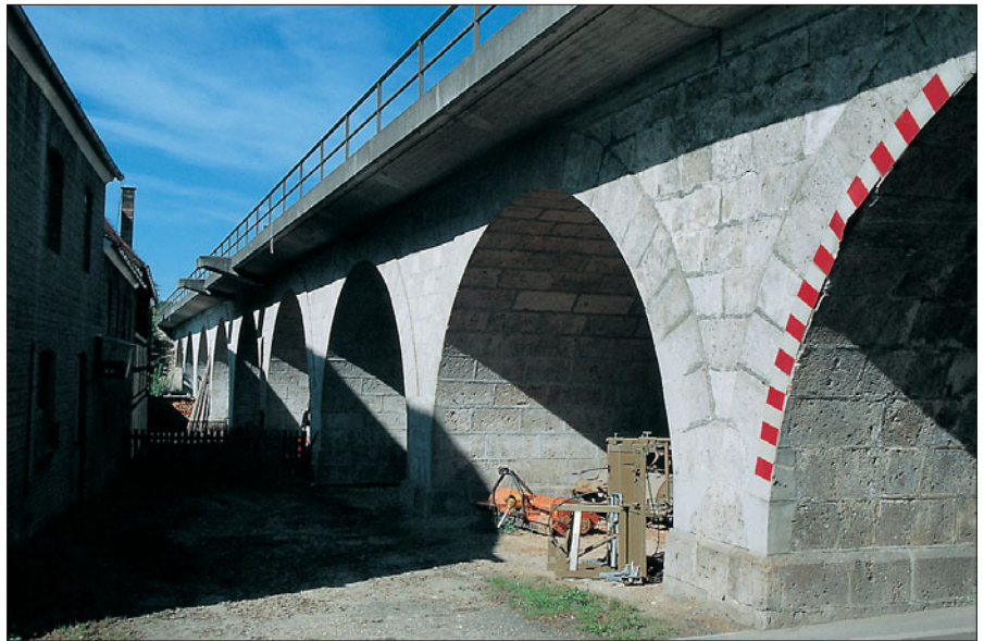
Dieses lang gezogene Viadukt mit seinen neun Bögen, deren Kämpfer sich nur knapp über dem Boden befinden, steht in Altensittenbach bei Hersbruck.
