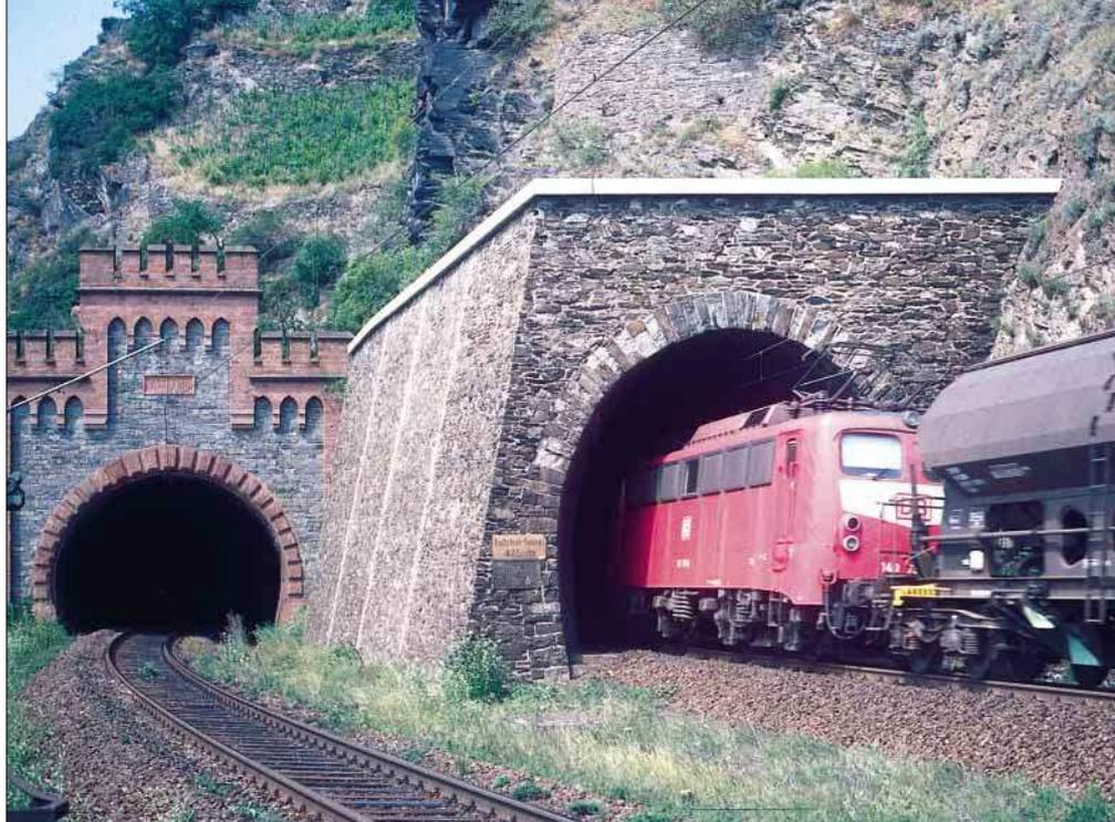
Die Elektrifizierung der rechten Rheinstrecke machte am Roßstein-Tunnel die Anlage einer zweiten Tunnelröhre notwendig.
