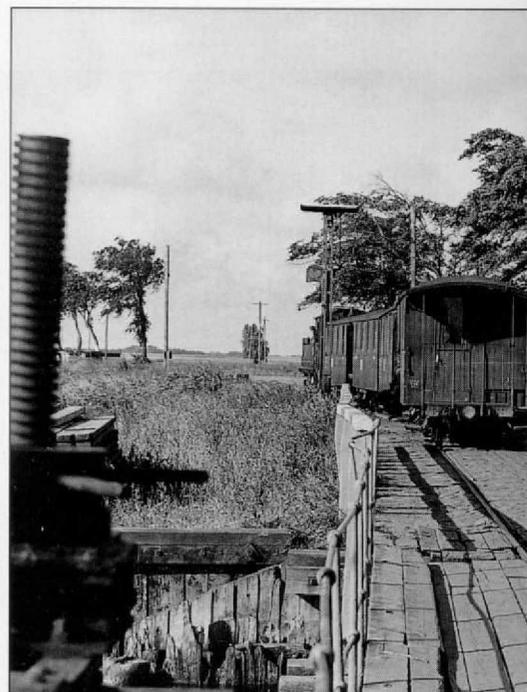
Szene in Fährhof am 26. Juni 1960. 99 4602 zieht Wagen von der Fähre. Das Schmal-spurbahn-Trajekt verband zwei durch einen hier 500 Meter breiten Meeresarm getrennte Teile des Rügener Kleinbahn-netzes. Das Brücken-Deckungssignal ist umgeklappt: „Fahrt frei“, jedoch mit fähr-engeignetem Tempo. Foto: Günter Meyer
