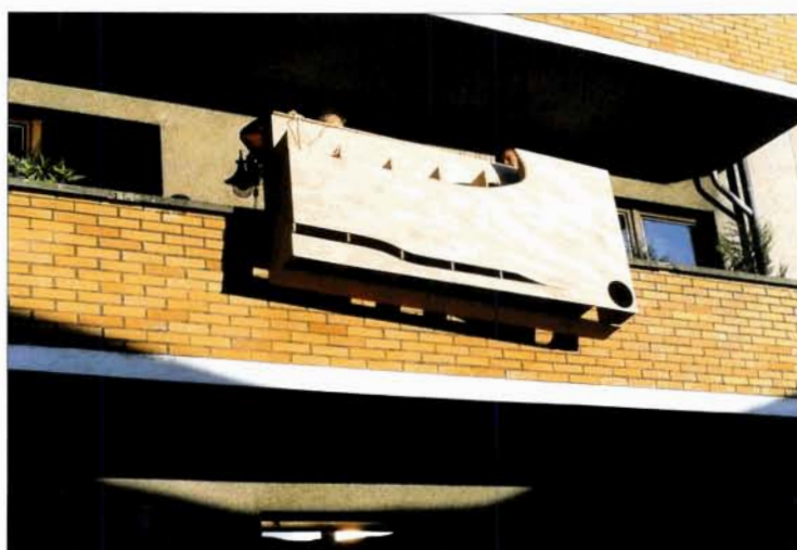
Bilder 21 und 22: Schnappschüsse vom Transport per Luftfracht des trotz sorgfältigen Messens nicht durchs Treppenhausepassenden längsten Anlagenmoduls.
