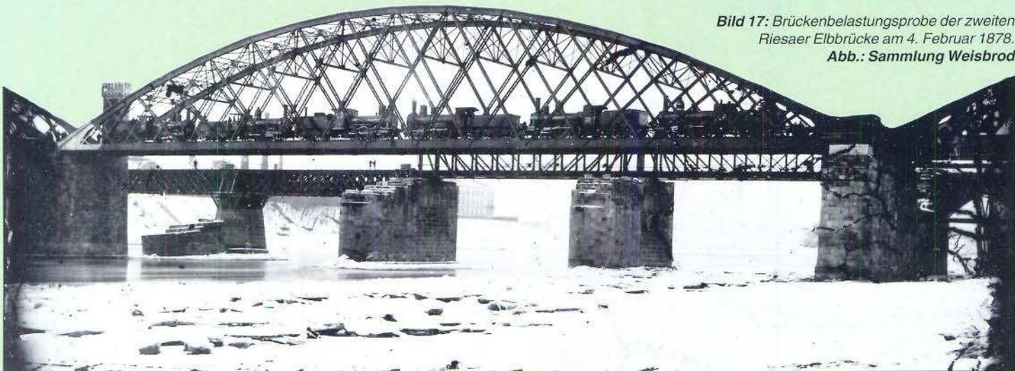
**Bild 17:** Brückenbelastungsprobe der zweiten Riesaer Elbbrücke am 4. Februar 1878.
