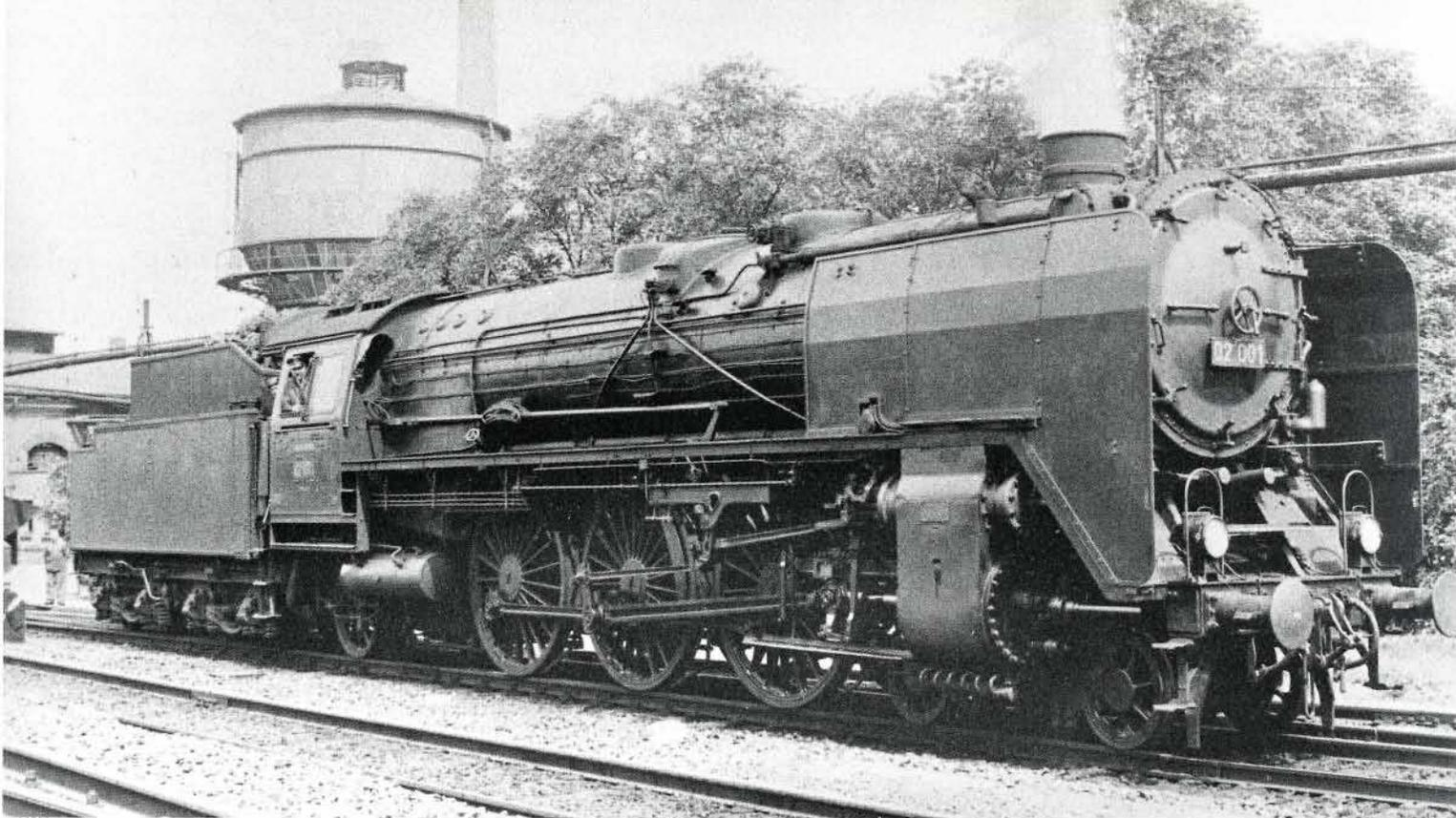
**Bild 5:** Die 02 001 war die erste deutsche Einheits-Schnellzuglokomotive. Auf diesem Foto präsentiert sie sich bereits mit den großen Wagner-Windleitblechen.
