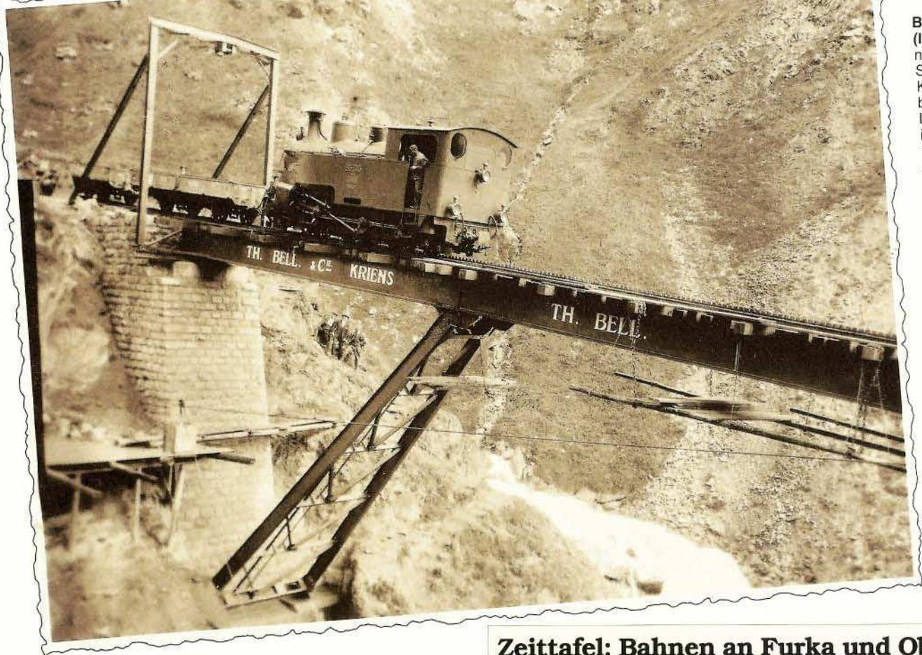
**Bild 14 (links):** Die neugebaute Steffenbach-Klappbrücke bei der ersten Lastprobefahrt im August 1925. **Abb.:** Archiv FO
