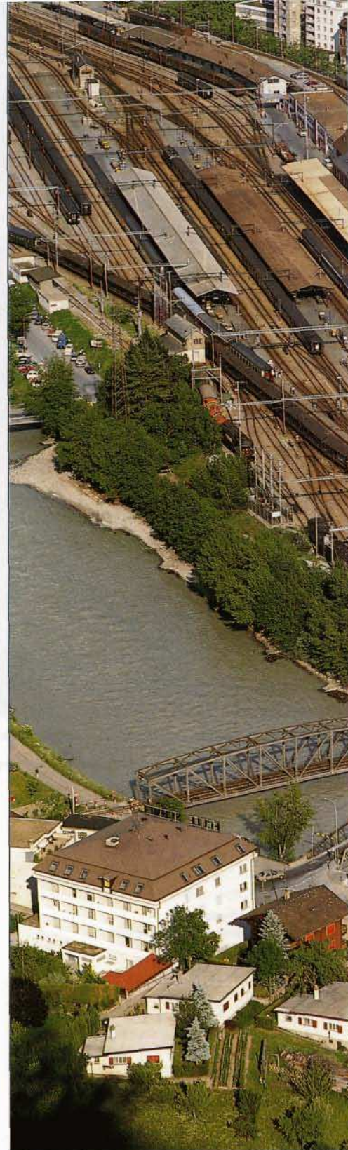
Bild 3: Panorama der Bahnhoferanlagen in Brig. Zwischen den Normalspurgleisen der BLS und der SBB (links) sowie den Schmalspurgleisen der BVZ und FO (rechts) liegt das Empfangsgebäude. Die BVZ-Strecke verschwindet am rechten Bildrand hinter dem Depot der FO. Foto: K. Fader
