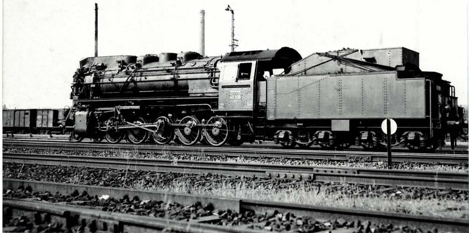
Bild 7: Die Lokomotiven der Baureihe 43 bekamen nur vereinzelt die großen Windleitbleche der Baureihe 01. Wie hier bei der 43 035 wurden verschiedene Formen von Windleiteinrichtungen erprobt. Foto: Dr. Feißel, Sammlung Dr. Scheingraber
