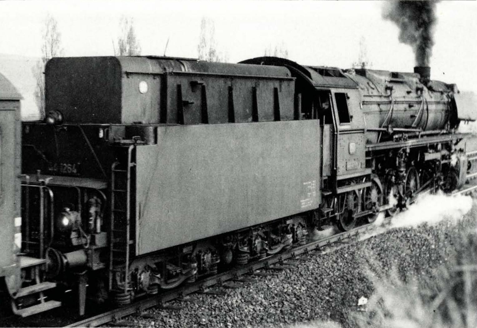
**Bild 9:** Eine der beiden bereits im Jahr 1958 bei Henschel in Kassel mit einer Ölhauptfeuerung ausgerüsteten Maschinen war die 44 1264 vom Bw Bebra. Noch im Frühjahr 1961 fuhr die Lokomotive mit einem Tender der Ursprungsausführung ohne das hintere Steigrohr. **Foto: Claus**
