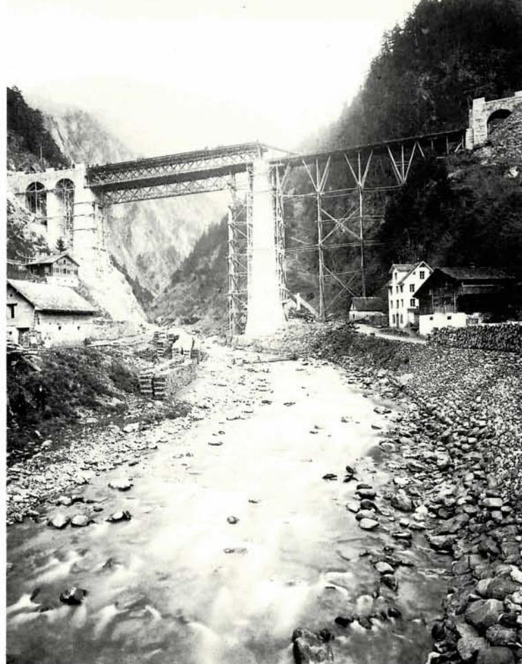
**Bild 8:** Der noch im Bau befindliche Kerstelenbach-Viadukt um 1880.
