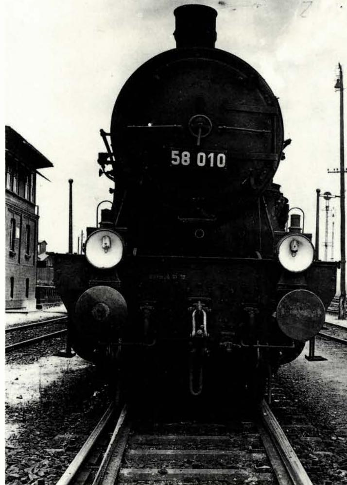
**Bild 11:** Die Pufferbohlenanschrift der 58 010 (preuß. G 12<sup>1</sup>) trägt die Aufschrift: Untersuchung Paderborn 8.10.32. Auffällig die hohe Pufferbohle.
