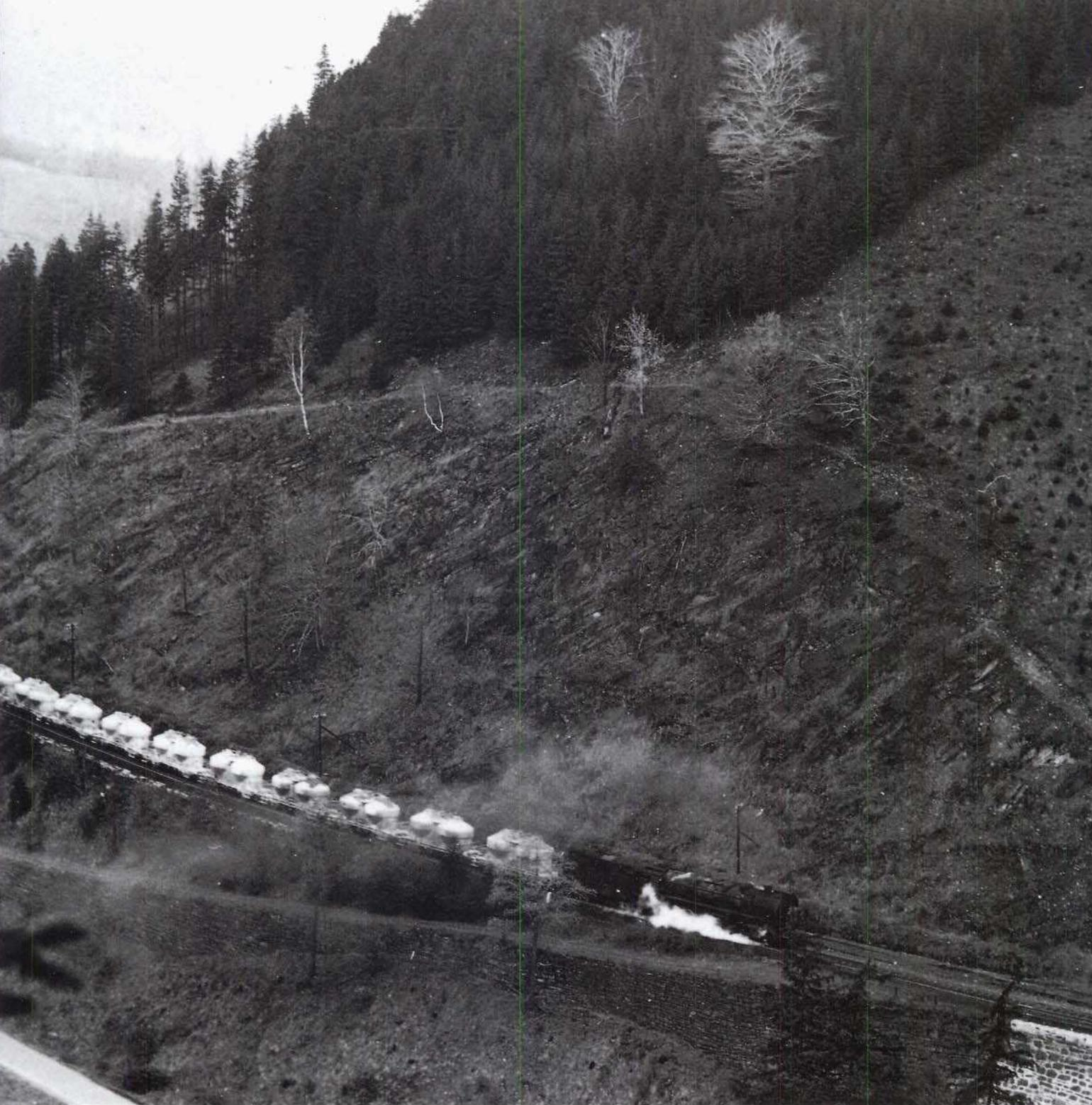
oberhalb des Haltepunkts Dörrberg, bevor auf einer 8 km langen Rampe der Bahnhof Gehlberg erreicht wird. Der Abschnitt Gehlberg – Oberhof ist nach 1945 von der Demontage des zweiten Gleises verschont geblieben. Ab Gräfenroda (379 m über NN) mußten nahezu alle Züge nachgeschoben werden, um den Bahnhof Oberhof (639 m über NN) zu erreichen. Das entsprach einer durchschnittlichen Steigung von 1:50.
